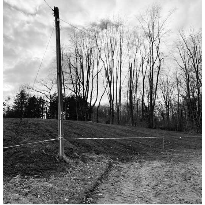
Abbruch Martinshöhe Kosten 65.500,- € davon 52.400,- € Fördermittel
